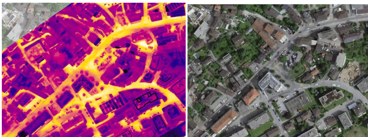
Figura 30: Dettaglio zona incroci S. Gottardo (termoimmagine: rif. rilievo ore 22:00)
