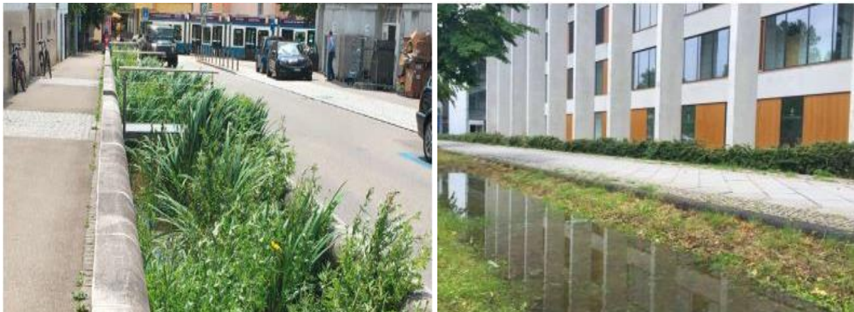
Figura 66: Sinistra: rinaturazione del Nebelbach, in centro a Zurigo; destra: le acque di pioggia vengono raccolte in una depressione verde del terreno, appositamente realizzata sul piazzale, con scopo di raccolta acque e di mitigazione della temperatura (Adlershof, Zurigo) (Fonte: UFAM (ed.) 2018: Ondate di calore in città: basi per uno sviluppo degli insediamenti adattato ai cambiamenti climatici).
