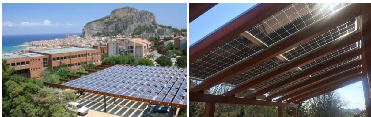
Figura 71: Esempio di piazzale fotovoltaico a copertura completa
