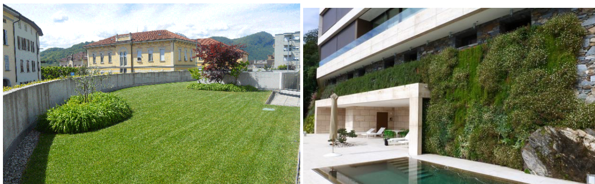
Figura 40: Esempi di edifici inverditi. A sinistra, il tetto verde dell'autosilo di via Motta a Mendrisio, a destra la parete di "verde verticale" su una villa di Ronco sopra Ascona (Fonte: http://www.soilbioengineering.ch/verde-verticale/ )
