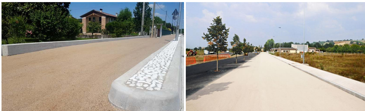
Figura 50: Esempi di strada cittadine in asfalto drenante di colore chiaro (Fonti: sinistra: https://www.buchestradali.com/ ; destra: https://www.lavoripubblici.net/pavimentazioni-chiare-un-nuovo-legante-trasparente-evizero-per-soluzioni-economiche-ed-alte-prestazioni/ ).
