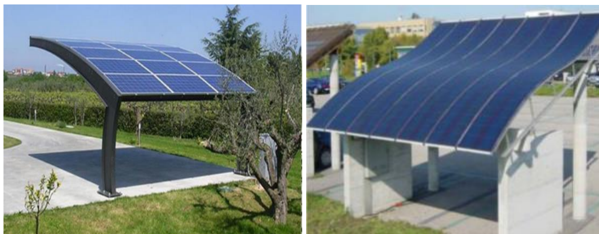
Figura 70: A sinistra e a destra: copertura parziale di piazzali con tettoie di pregio architettonico, dotate di pannelli solari (Fonti: sinistra: http://www.catech.ch/prodotti/fotovoltaico ; destra: https://www.fotovoltaico-lowcost.com )
