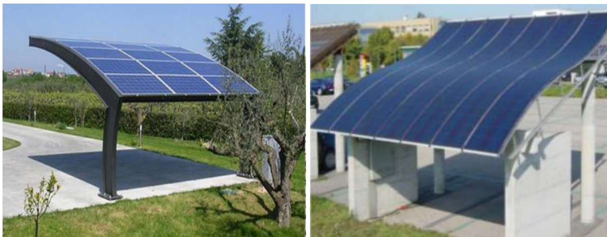
Figura 72: Copertura parziale di piazzali con tetterie di pregio architettonico, dotate di pannelli solari
