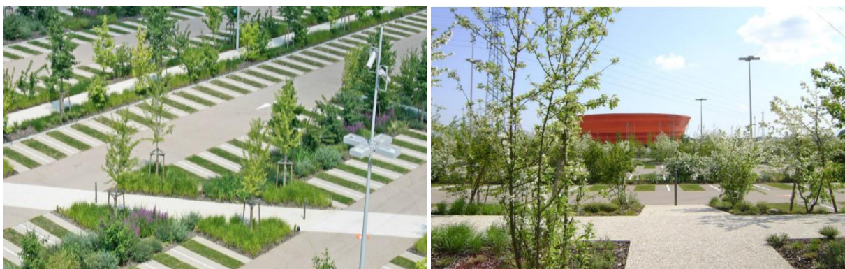
Figura 48: Esempio di aiuole inframezzate ai parcheggi e impermeabilizzazione della sola orma degli pneumatici (Parking du Zénith, Francia, Strasburgo) (Fonte: https://www.dipintosucci.com/blog/progettare-un-parcheggio-paesaggistico/ )
