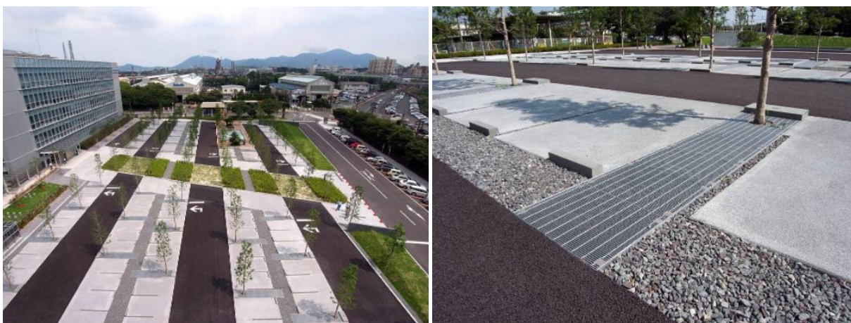
Figura 46: Gioco di pavimentazioni drenanti: tutta la pavimentazione del parcheggio è drenante (NSE Kitakyushu Technology Center, Giappone, Fukuoka, 2011) (Fonte: https://www.dipintosucci.com/blog/progettare-un-parcheggio-paesaggistico/ ).
