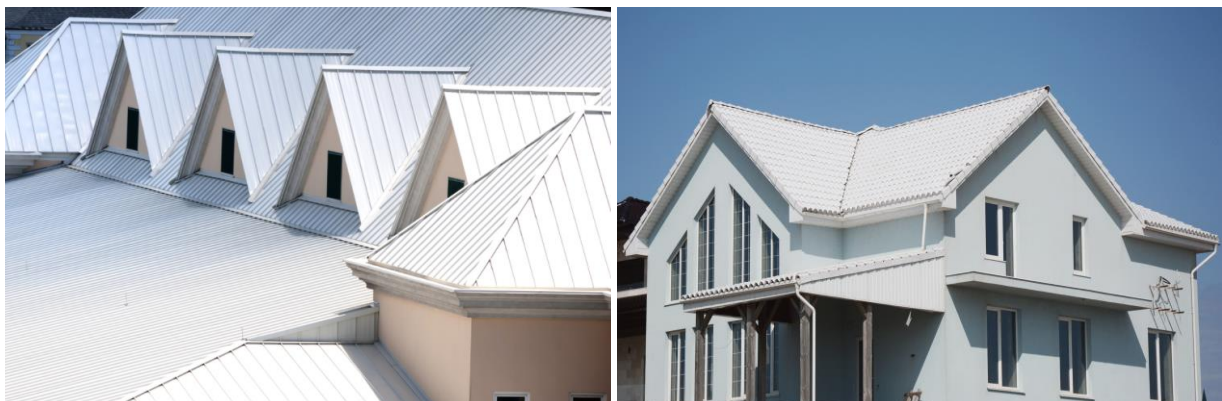
Figura 75: Esempi di applicazione di cool-roof su edifici esistenti (Fonti: in alto: https://newscenter.lbl.gov ; in basso a sinistra: https://ichi.pro ; in basso a destra: https://newscenter.lbl.gov ).
